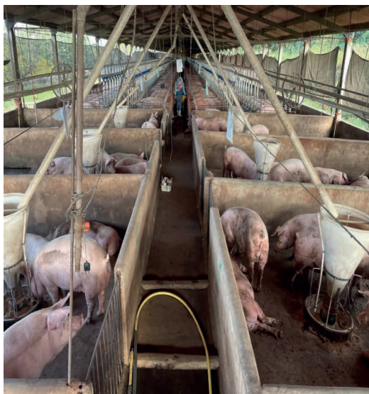
Figura 9. Terminação sem cama sobreposta e sem climatização especializada.
