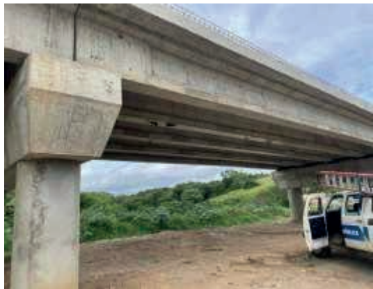
Figura 6 – Vista lateral direita mostrando longarinas, transversinas e pilares Fonte : Autores (2024)
