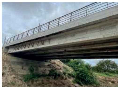
Figura 5 – Vista lateral direita mostrando longarinas, encontro e guarda corpo Fonte : Autores (2024)
