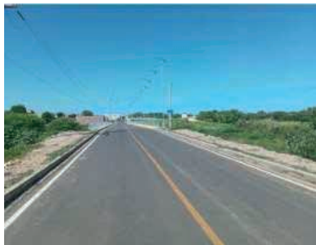
Figura 3 – Vista frontal da ponte Fonte: Autores (2024)
