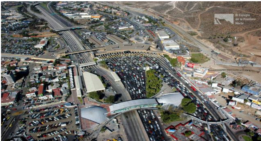
Figura 8: Imagen del Puerto Fronterizo Tijuana y San Isidro antes de la modernización
