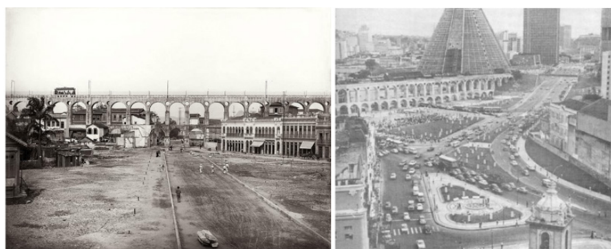
Figuras 8 e 9: Remoções na região da Lapa (Decourt, 2005); Obras concluídas da Avenida Norte-Sul (Decourt, 2005)
