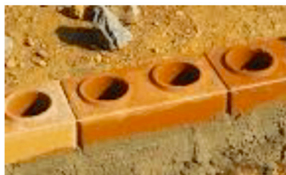
Figura 2.8 Implantação do modelo pot-in-pot M1 utilizando alvenaria de tijolo ecológico (Própria, 2016).
